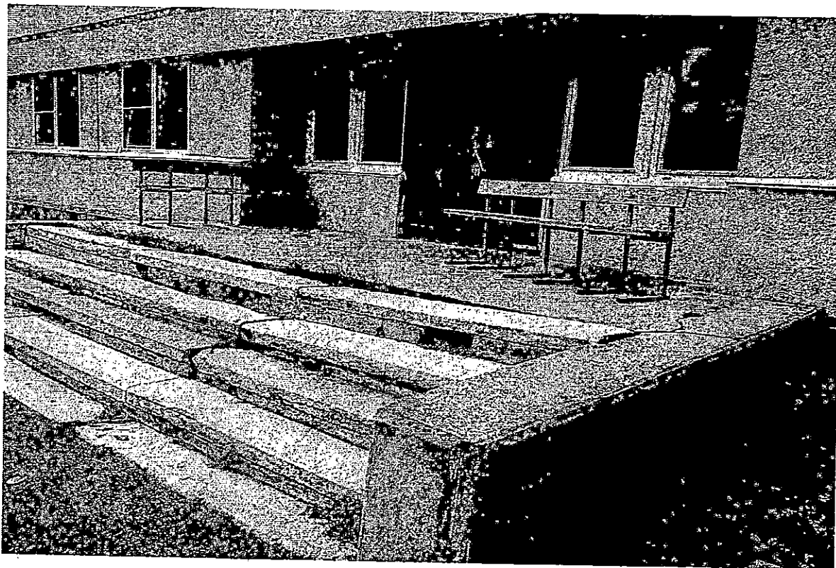
Ввиду просадки грунтового основания для проступей, проступи имеют различные продольные уклоны.
